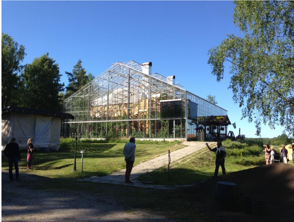
Klimatskalet – växthuset – omger timmerhuset innanför, där familjen bor (foto Göran Värmbby)
