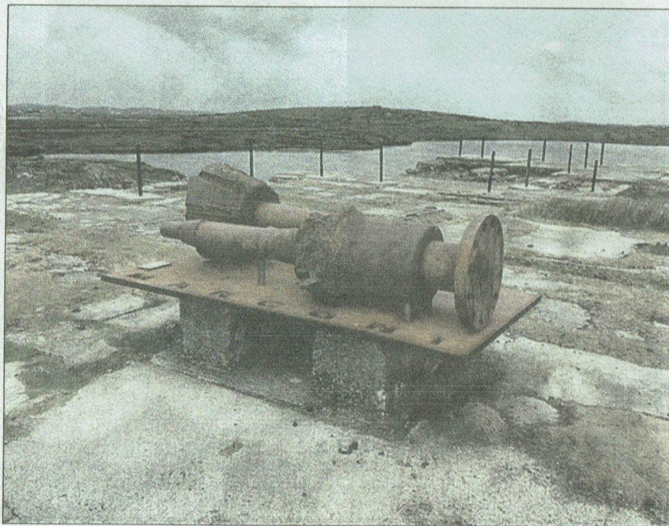
En av de fyra likströmsgeneratorerna à 5000 volt ligger fortfarande kvar i ruinerna efter the Power House.
